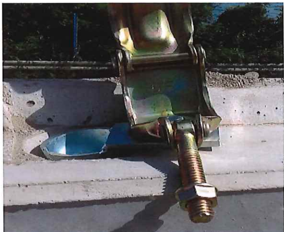
5. クランプのボルトを締め付ける
