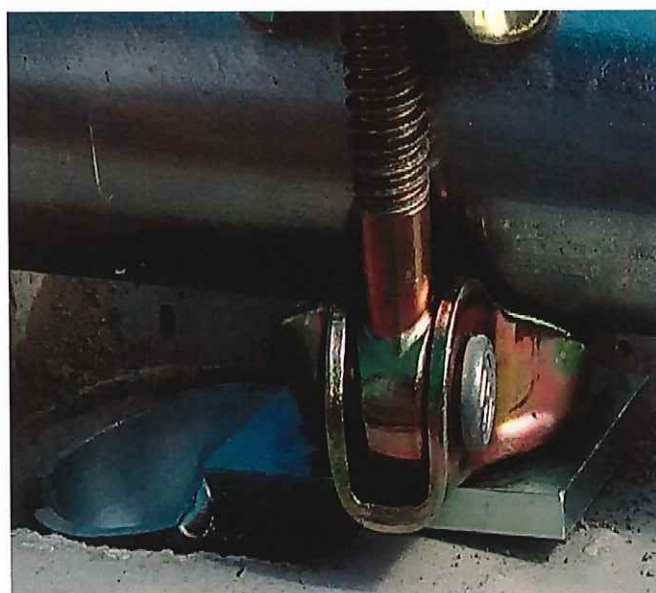
6. 取付プレートと単管が平行になっていることを確認して取付完了
