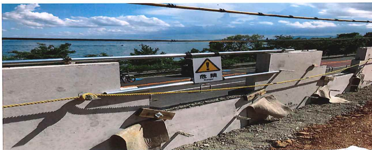
取付完成写真
