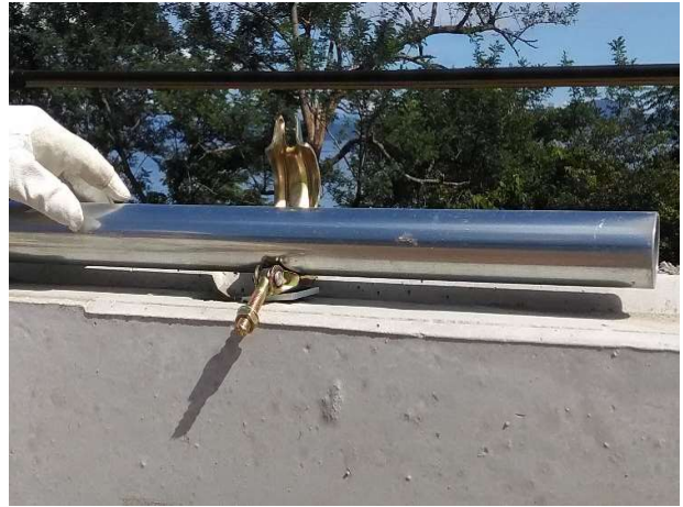
6. 取付プレートと単管が平行になっていることを確認して取付完了
