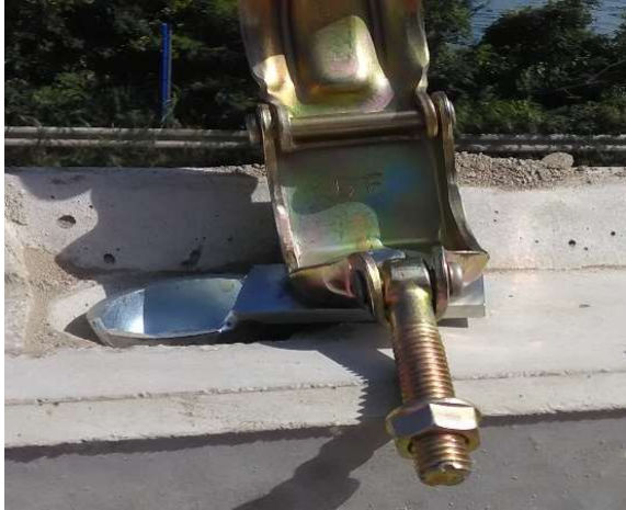
5. クランプのボルトを締め付ける
